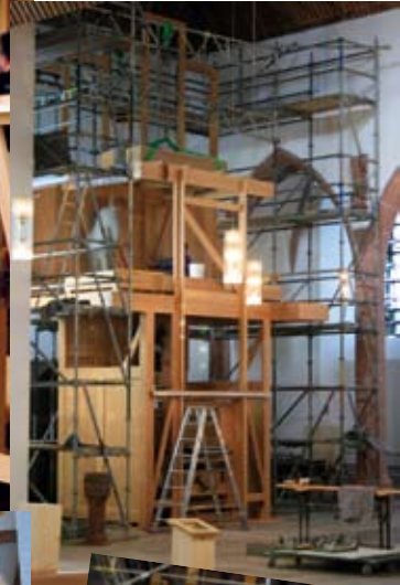
24.09.: „Erdgeschoss“ und „1.Etage“ stehen nach nur einem Tag!
